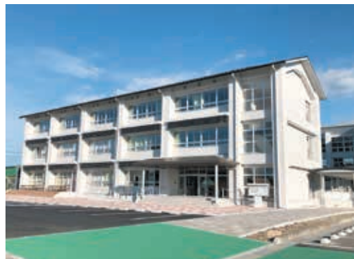
佐賀北高校通信制校舎内に設置
