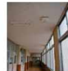
廊下にアクセスポイントを設置した例 (哲西中学校)
