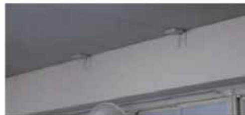
普通教室に2台アクセスポイントを設置した例 (三雲中学校)
