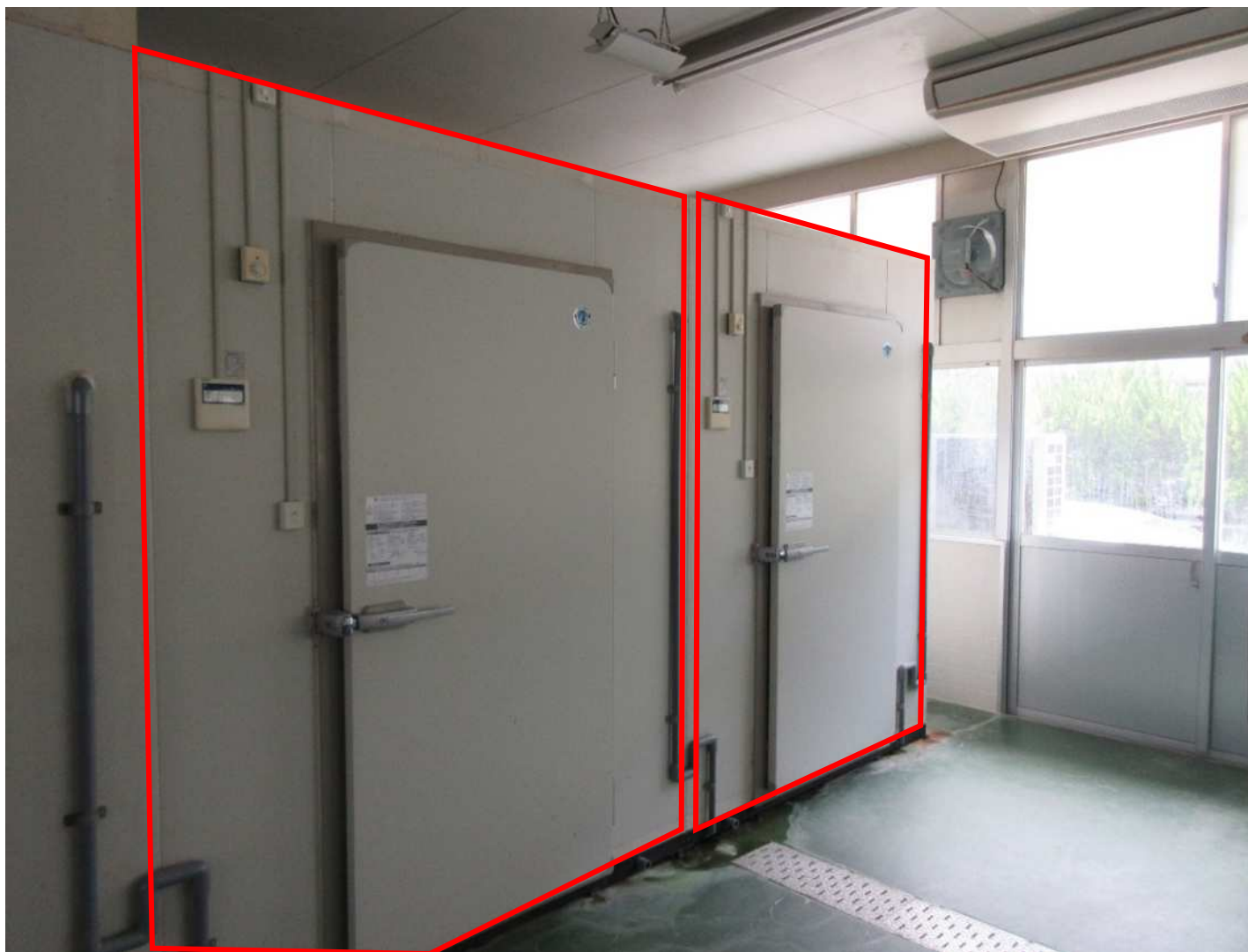
既存のプレハブ冷蔵庫2台を撤去し、新規機器を搬入する。
