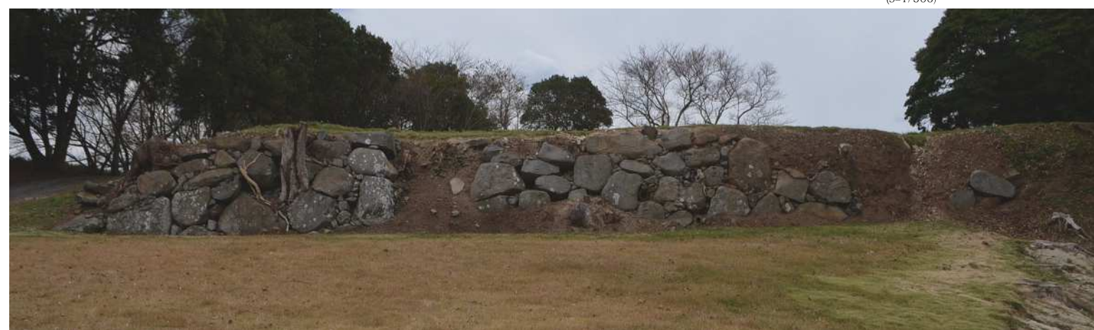
石垣修理箇所 弾正丸 (238 面) 石垣 (北東から)
