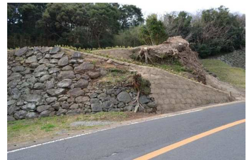
北側法面 (東から見る)
