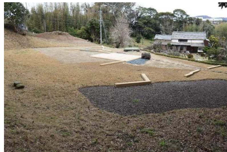
平面遺構表示 (西から見る)
