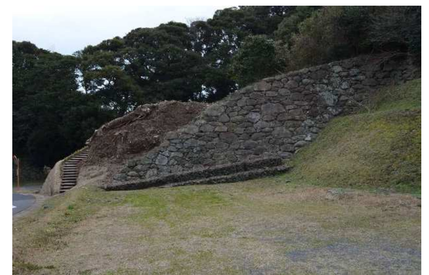
北側法面 (北西から見る)
