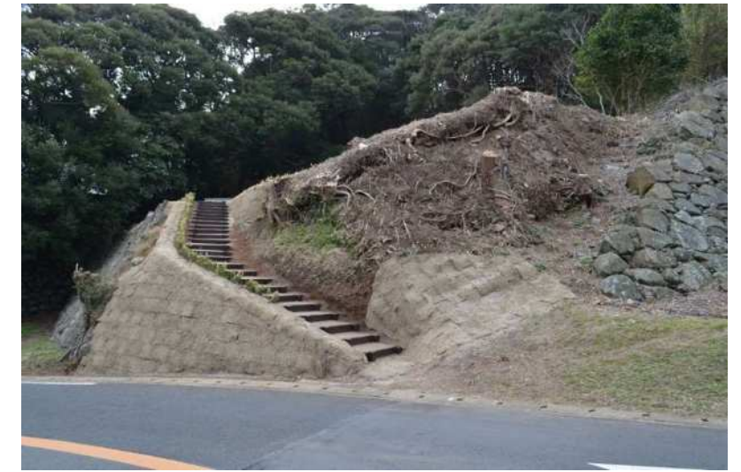
北側法面 (北から見る)
