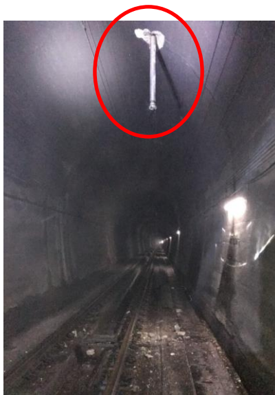
トンネル上部 地質調査(ボーリング作業)
