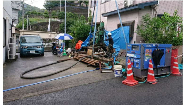
トンネル上部 地質調査(ボーリング作業)
