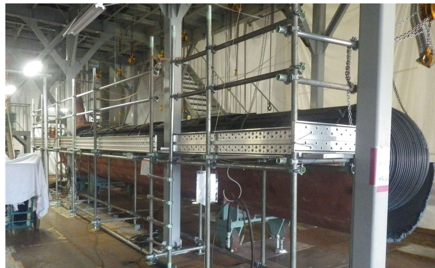
【高圧給水加熱器の解体撤去の状況】
