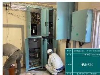
古木場ダム管理棟（有田町）
