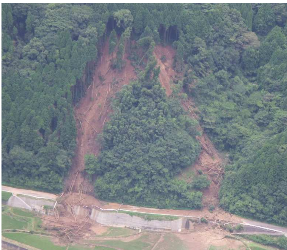
平成30年7月6日の梅雨前線集中豪雨により被災 (伊万里市東山代町滝川内 鍋倉地区)
