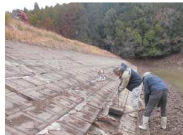
ため池の軽微な補修
