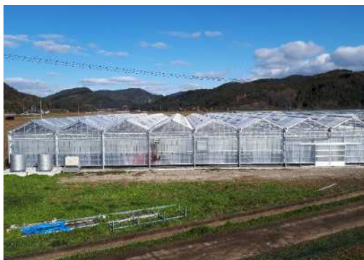
軒高4mのフェンロー型耐候性ハウス
