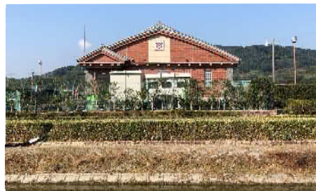
農業集落排水処理場
