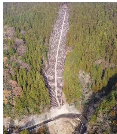
工事完了（山腹工事）
