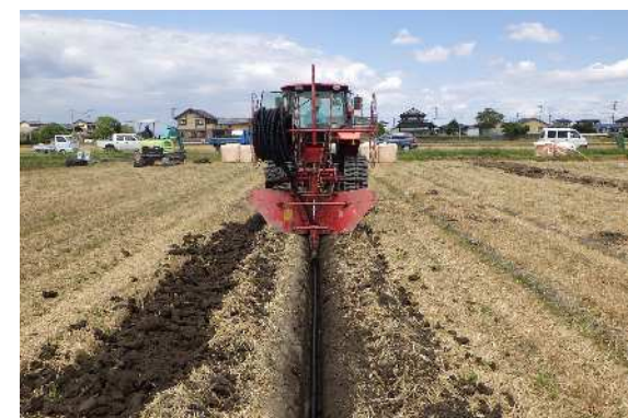
暗渠排水の整備
