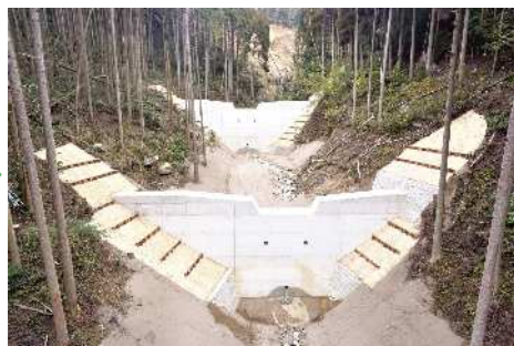
工事完了（溪間工事）
