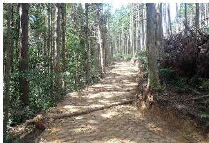
森林作業道の作設
