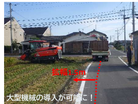
農道拡幅工事
