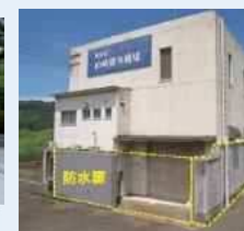
▶ 排水機場機能向上
