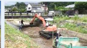
▶ 河川浚渫・伐採
