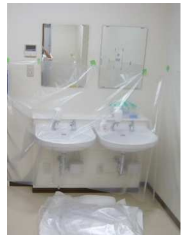
図_2-6 搬出できないものの養生の例
