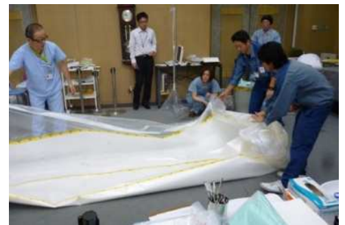
図_2-16 養生シートの撤去
