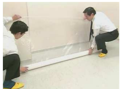
図_2-7 壁面養生の例
