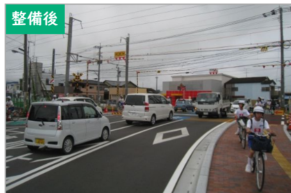
一般県道牛津停車場線（小城市）
