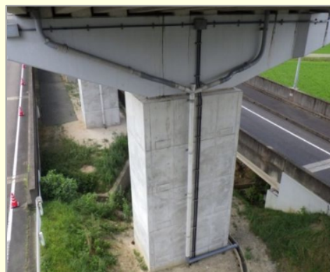
橋脚補強（コンクリート巻立）
