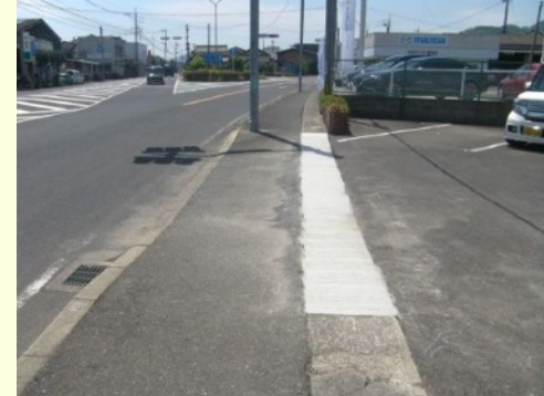
小規模補修（現場打ち側溝蓋設置）
