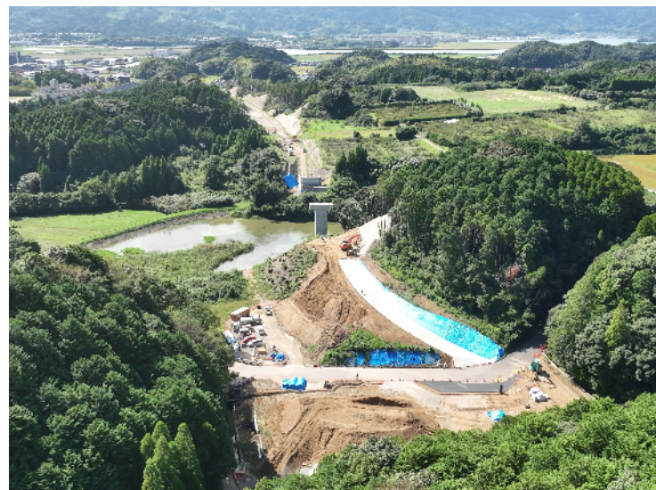
西九州自動車道 伊万里道路 木須地区（橋梁下部工、改良工）整備中（R6.10）
