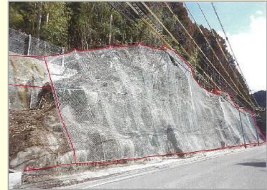
<整備事例> 落石対策
