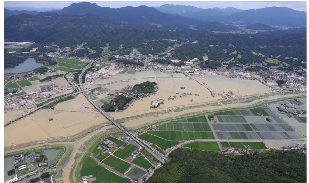
令和3年度内水氾濫状況（武雄市）
