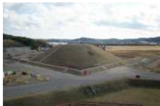
燃料タンク(館山航空基地)
