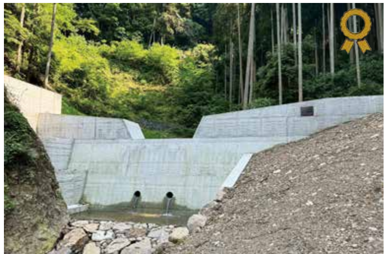
治山工事部門 最優秀賞（知事賞）小松原地区【（株）神近建設】
