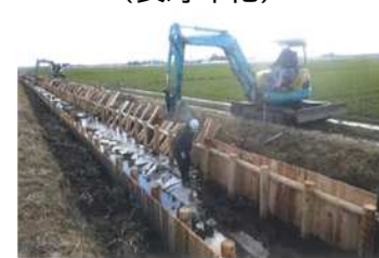
水路の木柵工
