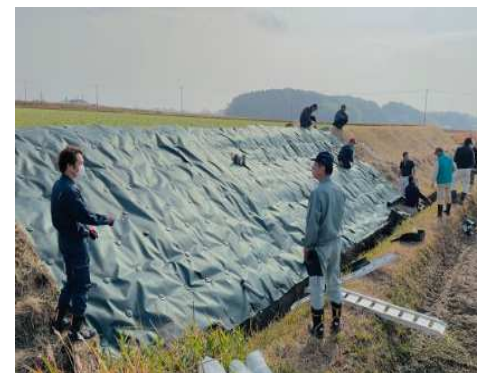
シート被覆による畦畔管理の省力化（みやき町）
