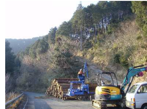
林道の活用状況（木材の集積） 九千部山横断線（鳥栖市）
