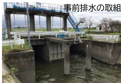
鯰江樋管（神崎市）
