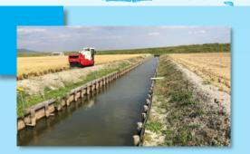
佐賀平野は、水田面積に対する山地面積 が小さく、乏しい水資源を効率よく反復利 用するため、「クリーク」と呼ばれる農業用 用排水路網が発達しています。
