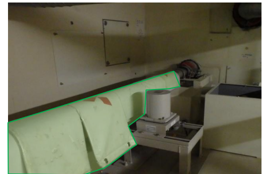
【鉛遮へい板設置後】
