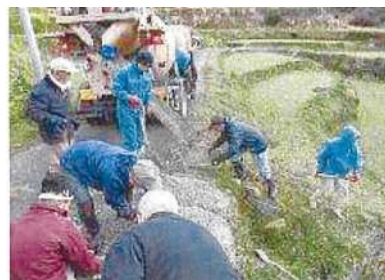
【地域住民による農道補修】
