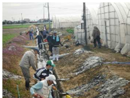
【水路内の泥上げ】
