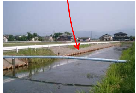
【木柵工による護岸整備】
