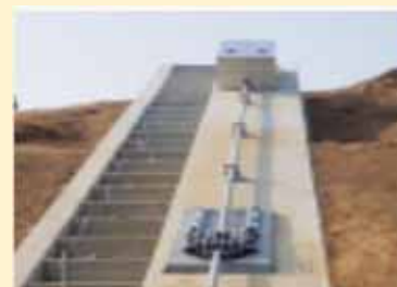
▶ ため池の緊急放流ゲート
