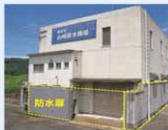
▶ 排水機場の機能向上
