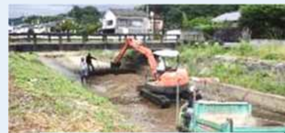
▶ 河川浚渫・伐採
