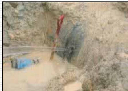
老朽化したパイプラインの漏水状況
