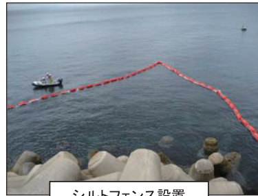
シルトフェンス設置
