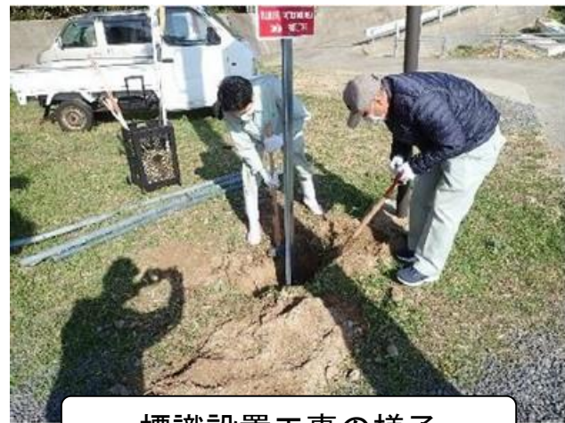
標識設置工事の様子
