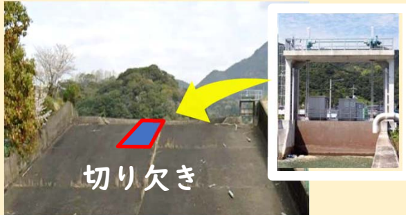
焼米ため池（武雄市北方町）
