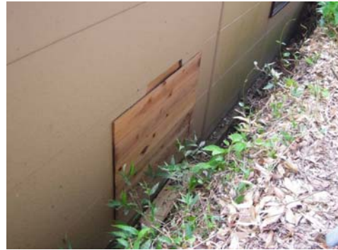
④ 料亭倉庫転石による破損状況
