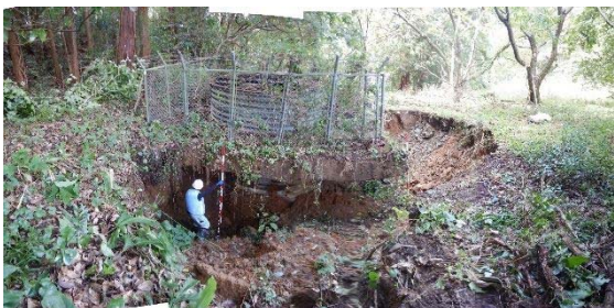
② 既設集水井工全景及び被災状況
