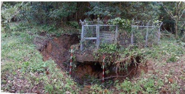
② 既設集水井工全景及び被災状況
