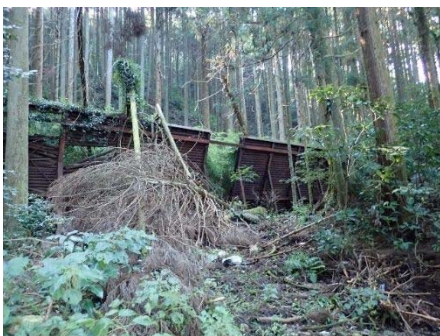
① 既設ダム遠景
