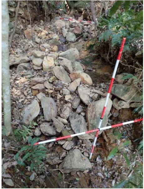
③ 不安定土石堆積状況
