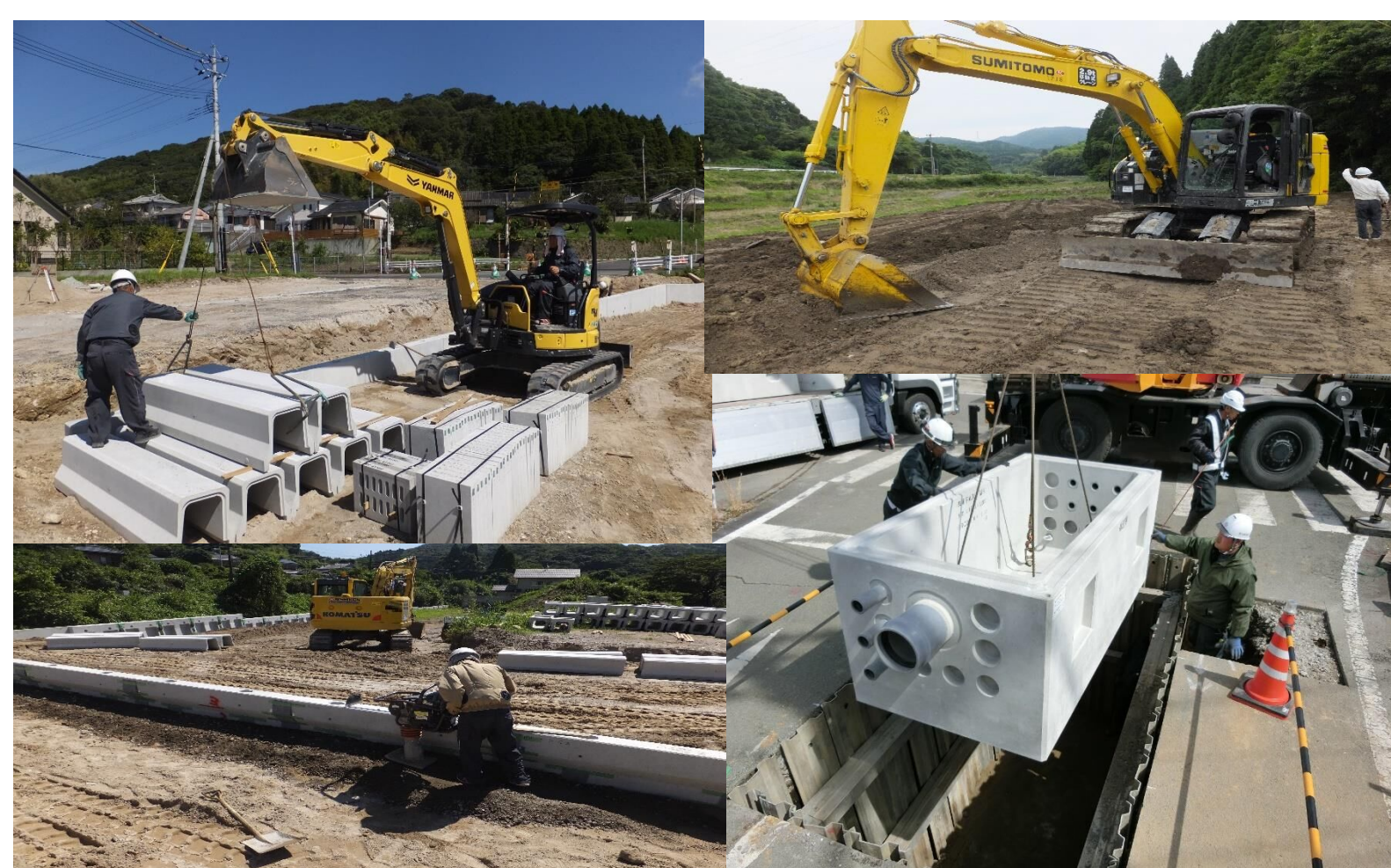
現場（電線類地中化事業他）の様子
