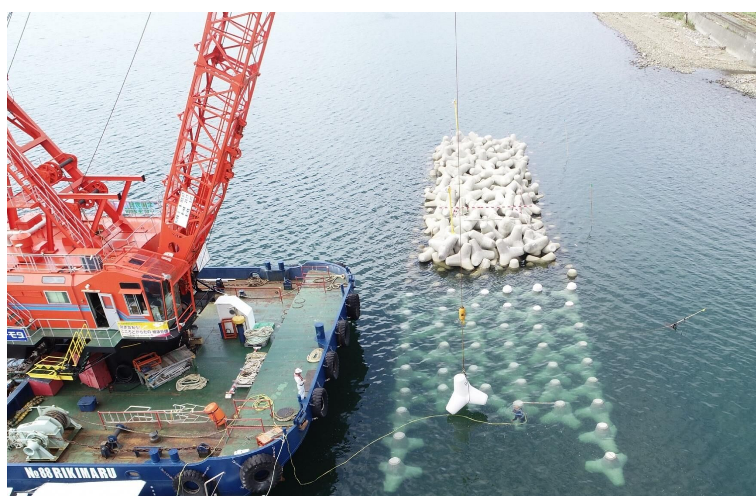
消波ブロック据付
