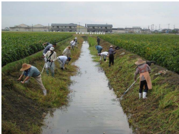
水路法面の草刈り
