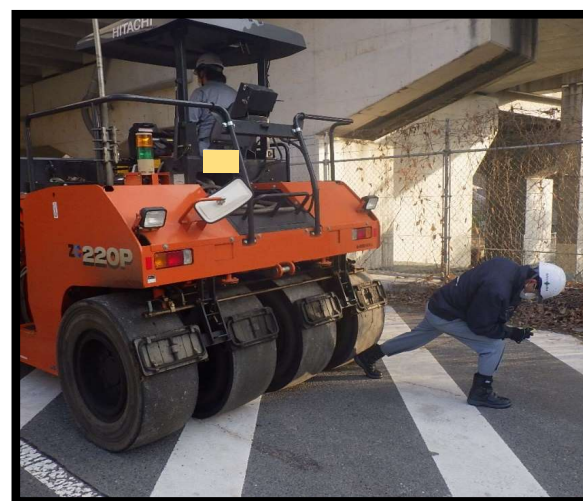
【被災状況(再現)】
