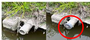
コルゲート管の閉栓
