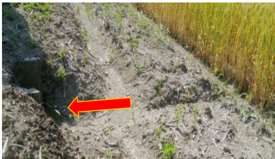
※排水溝に溝を繋げる
