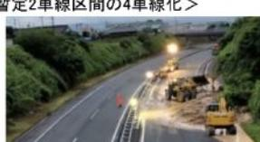
九州道で法面崩落が発生した際、4車線のうち被害のない2車線を活用し、約8時間で一般車両の下り線の通行を確保(約19時間後には一般車両の上下線の交通機能を確保)
