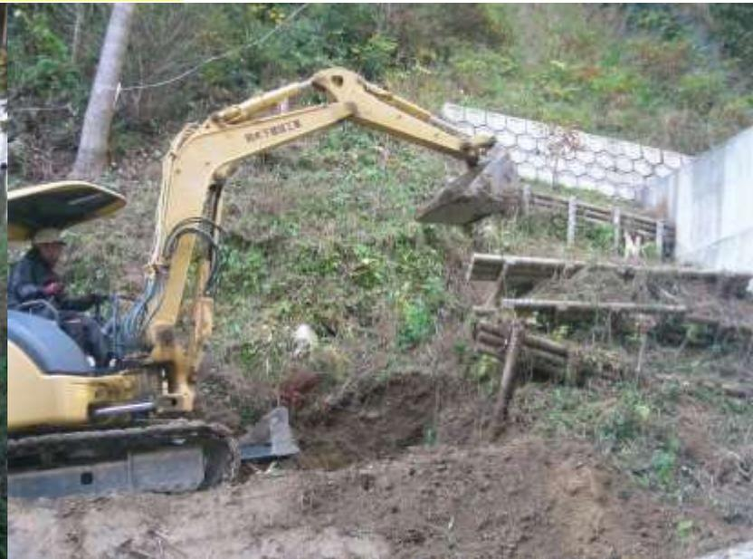
損壊した古い土留めを撤去して、当社が再度復旧しました。このままでは重機が入れないので、土砂を掘り起こして道を作りながら作業をしました。
