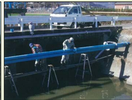
水管橋の塗装
