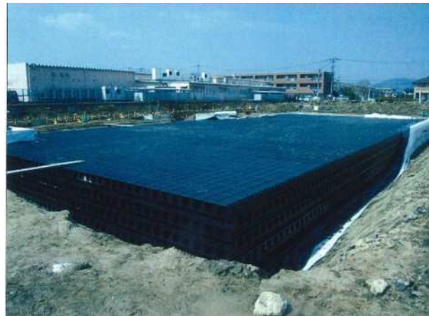
貯留施設設置状況
