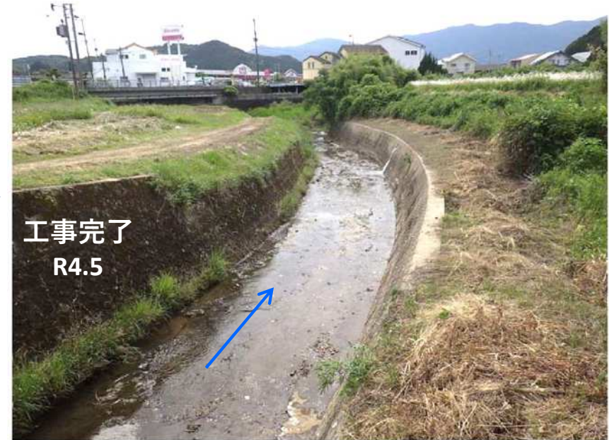
丸尾川（河道掘削状況）
