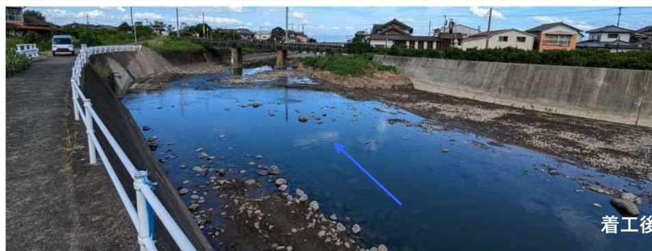
多良川（河道掘削）
