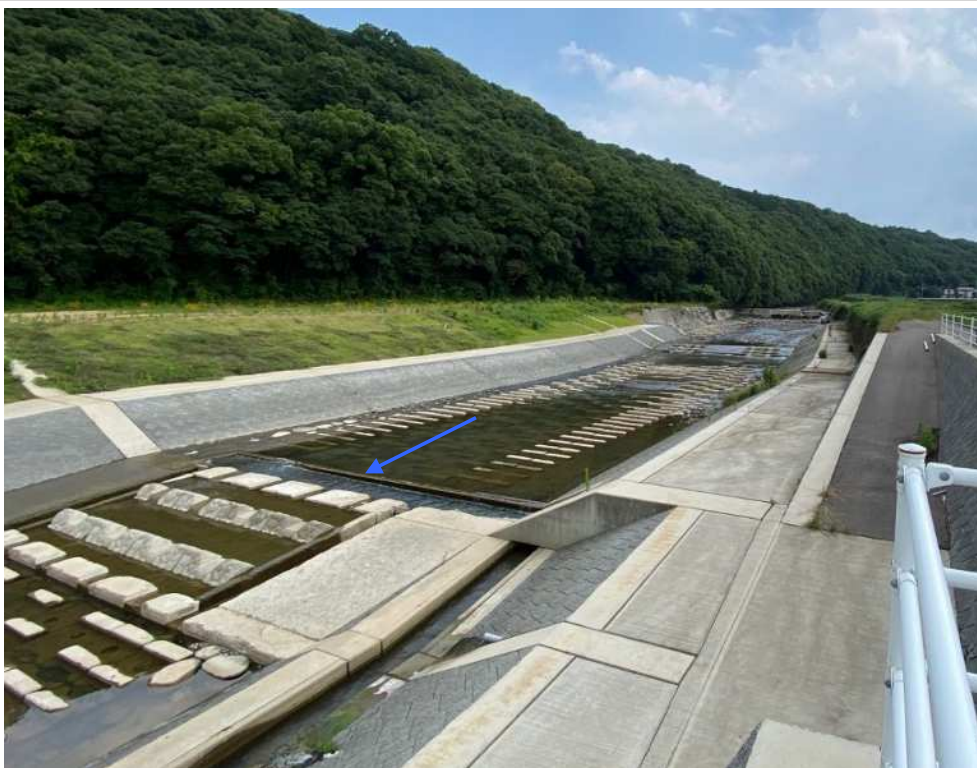
浜川（河道拡幅・床固）
