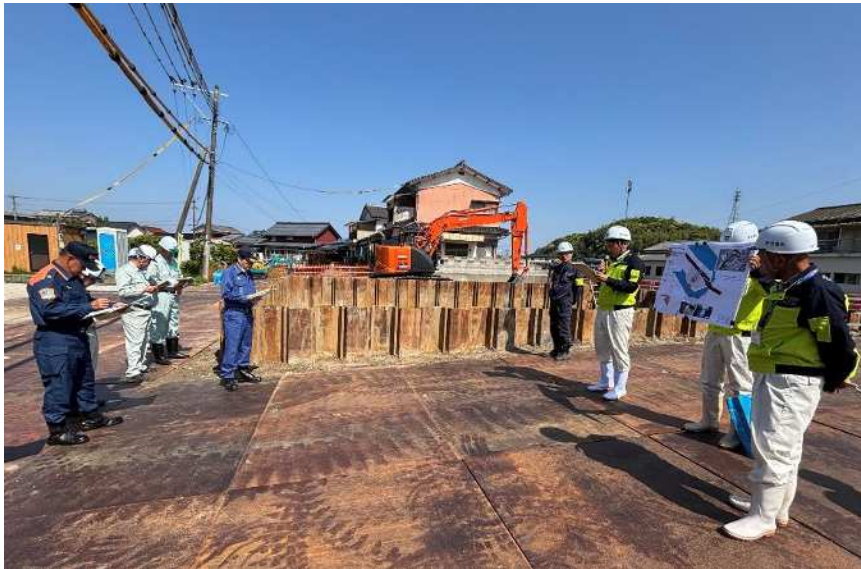
浦分地区浸水対策工事の現地(黒川町小黑川)で説明を受ける様子
