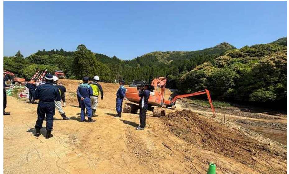
ため池整備事業の工事現場(大川町山口)で説明を受ける様子
