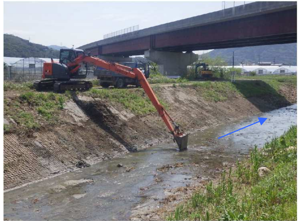
谷口川（河道掘削）
