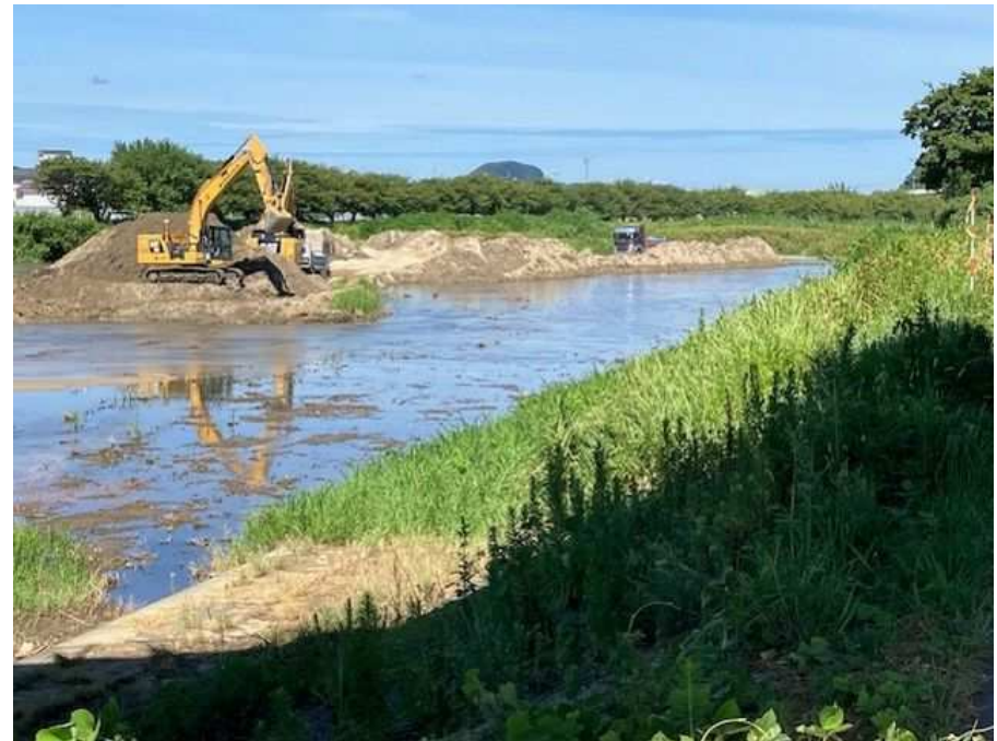
玉島川（河道掘削）
