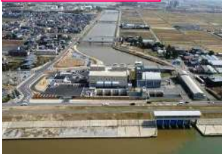
排水機場と周辺の市街地
