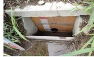
流出調整板設置の例
