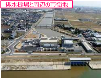
排水機場と周辺の市街地
