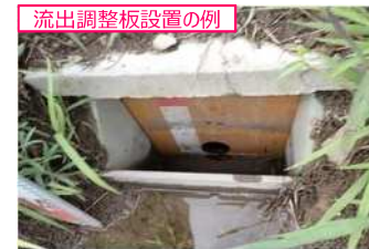
流出調整板設置の例
