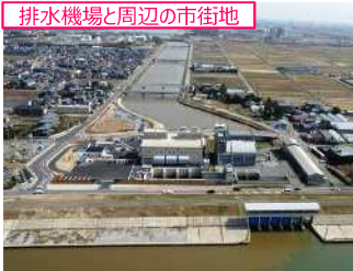
排水機場と周辺の市街地
