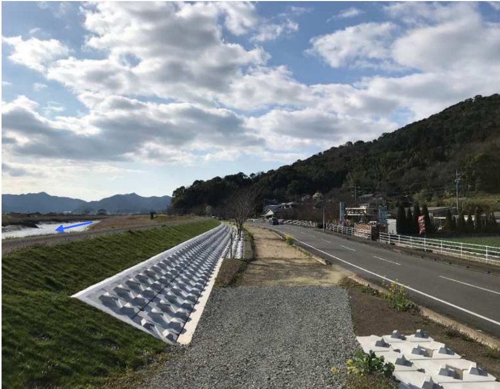
塩田川（堤防法尻補強）
