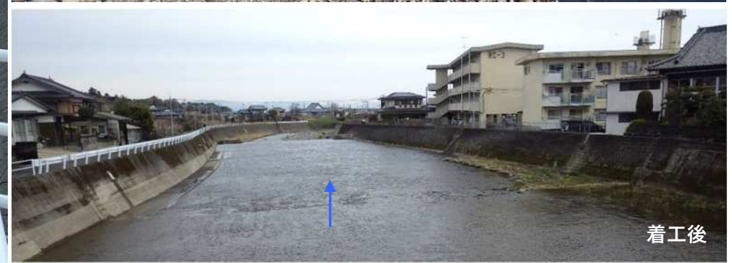
多良川（河道掘削）
