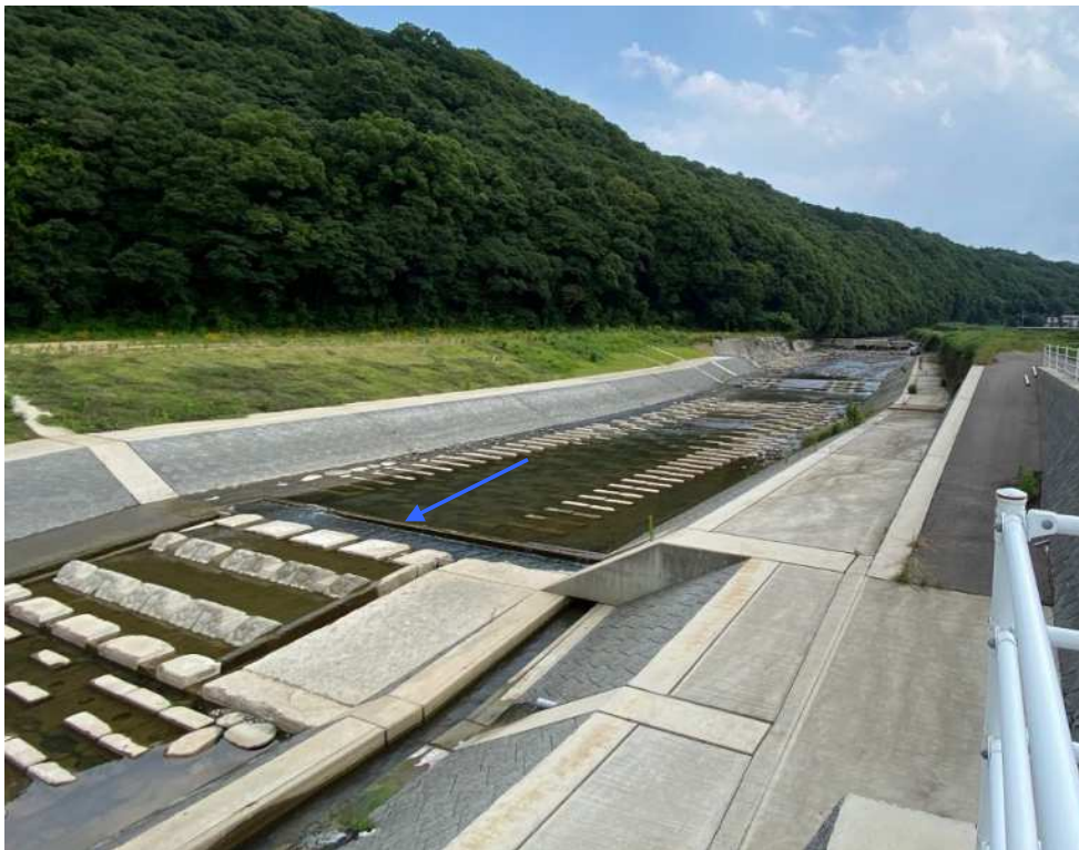
浜川（河道拡幅・床固）
