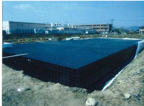
貯留施設設置状況
