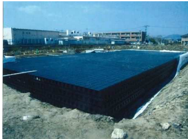
貯留施設設置状況
