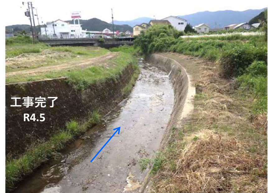
丸尾川（河道掘削状況）
