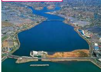
排水機場と周辺の市街地
