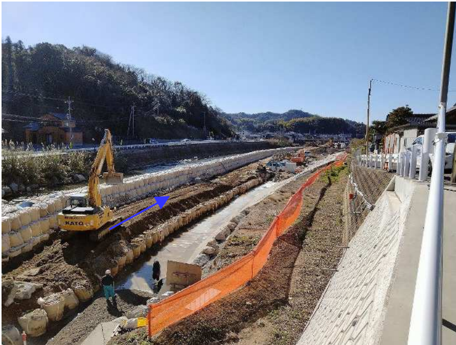
玉島川（河道拡幅、護岸）
