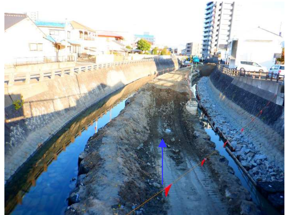
町田川（河道掘削、根固）
