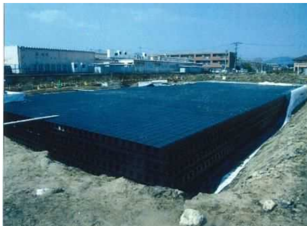
貯留施設設置状況
