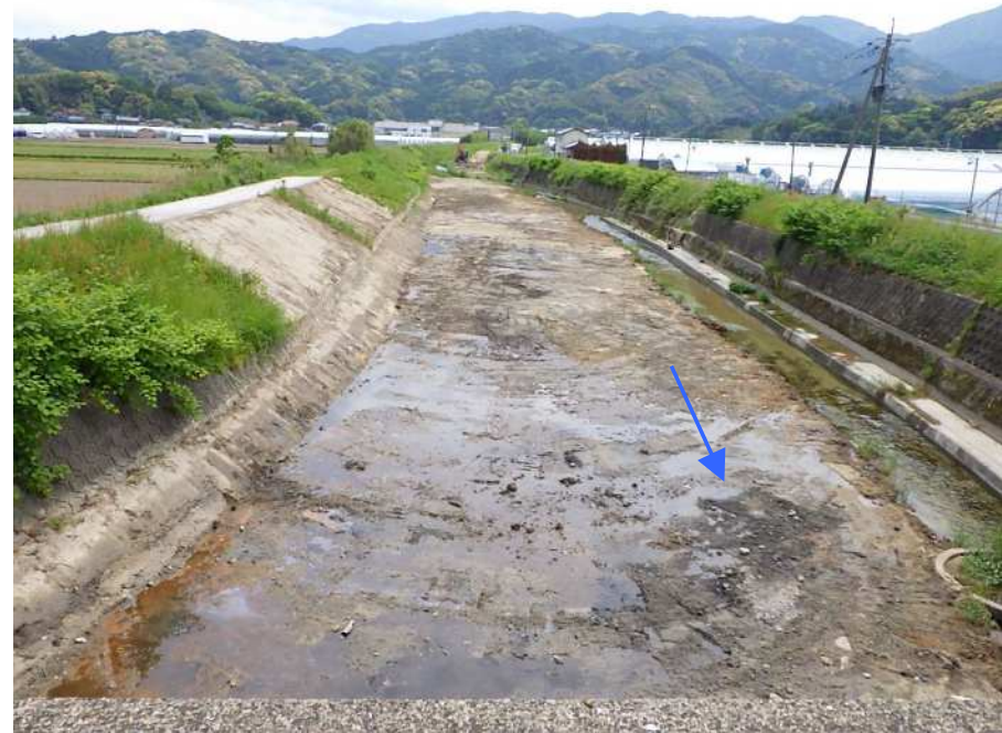
半田川（河道掘削）
