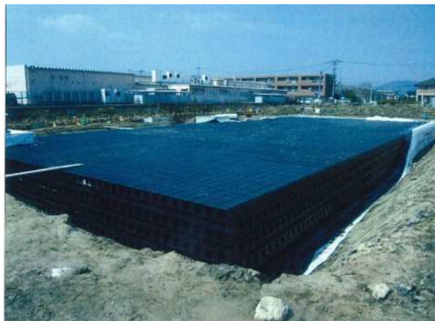
貯留施設設置状況
