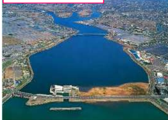
排水機場と周辺の市街地
