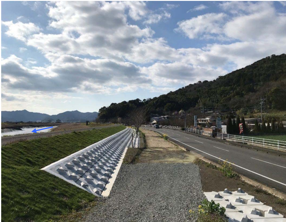
塩田川（堤防法尻補強）
