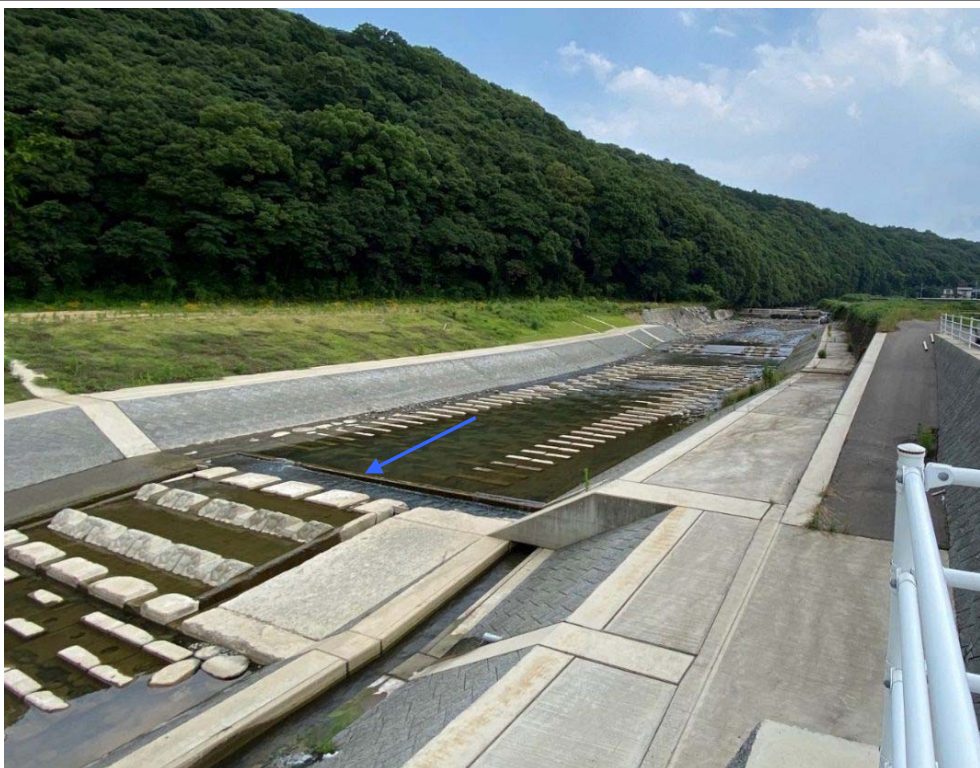
浜川（河道拡幅・床固）
