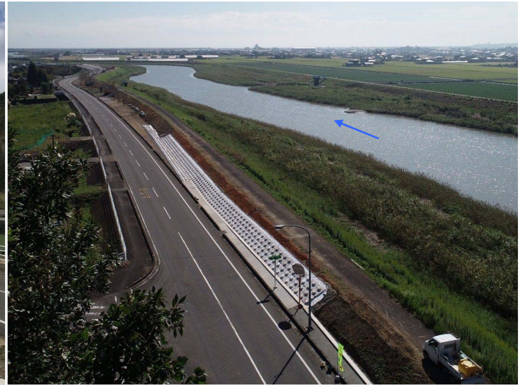
塩田川（堤防法尻補強）
