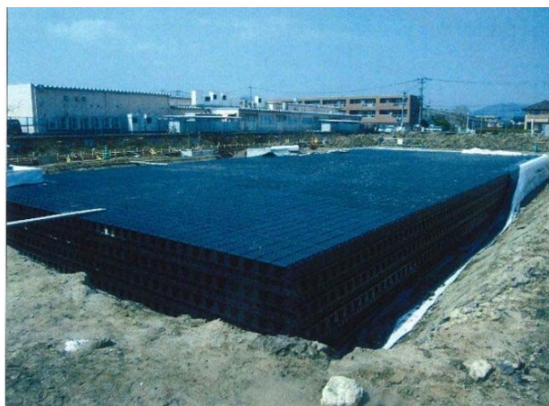
貯留施設設置状況
