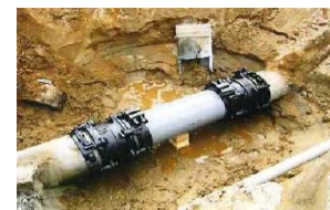
漏水防止のための整備
