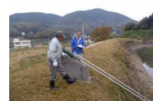
ため池の現地パトロール
