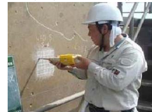
老朽化した施設の機能診断
