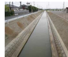
排水路の整備
