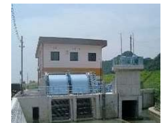
排水機場の整備
