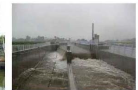
(排水分水ゲート)
