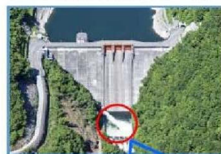
放流設備からの放流状況
