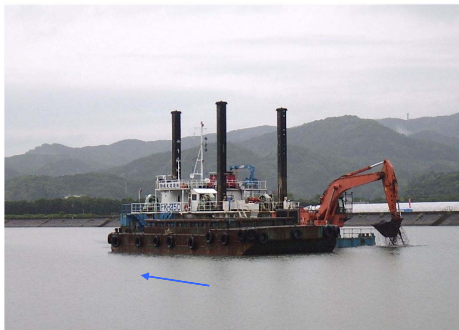
有田川（河道掘削）
