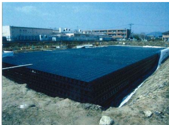
貯留施設設置状況
