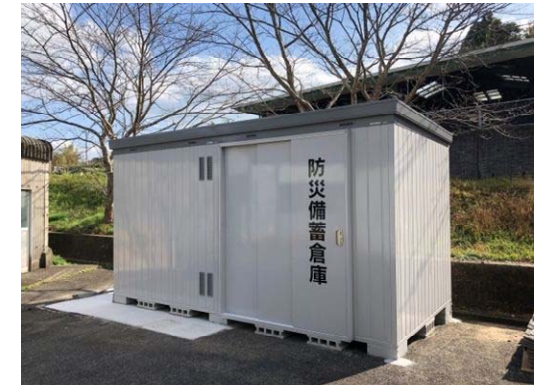
市内の13避難所(コミュニティセンター)に防災用備蓄倉庫を設置
