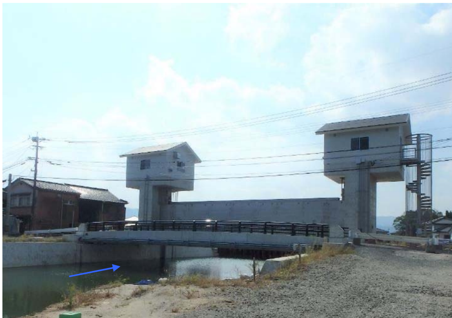
立川（水門設置）
