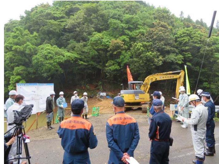
ため池の改修状況及びハザードマップについて説明している様子
