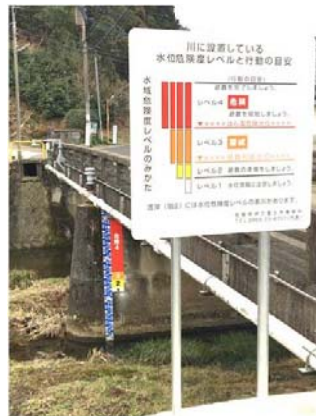
有田川 菅野橋[水位レベル表示] (有田町)
