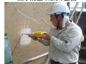
老朽化した施設の機能診断
