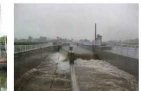
（排水分水ゲート）
