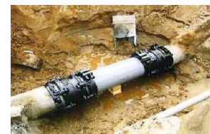
漏水防止のための整備
